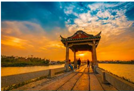
สะพานอันผิง
